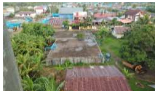
Gambar 5. Bak penampungan air
