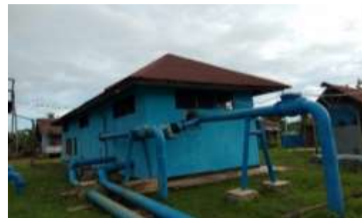
Gambar 4. Rumah pompa muli
