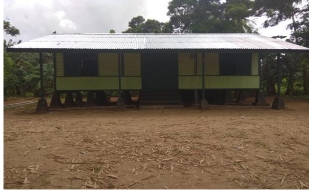
Gambar 4 Rumah Lepro Setelah Pemugaran Sumber Dokumentasi, 2017
