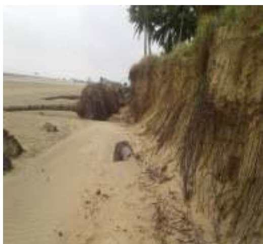
Gambar 4. Akibat Erosi dan Abrasi
