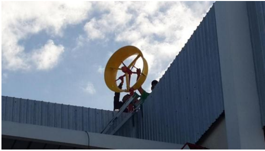
Gambar 5.1 Turbin angin yang telah terpasang di atas gedung
