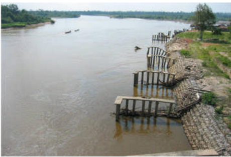
Gambar 3. Krib Permeabel dengan Tiang Pancang
