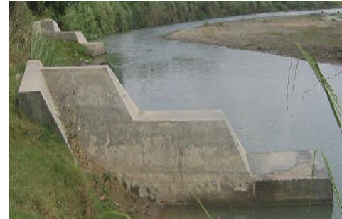
Gambar 4. Krib Impermeabel dengan Beton
