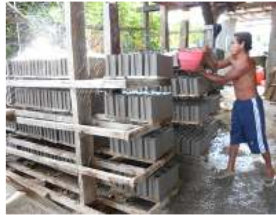
Gambar 5. Proses penyiraman batako beton mekanis (Sumber: hasil dokumentasi, 2016)
