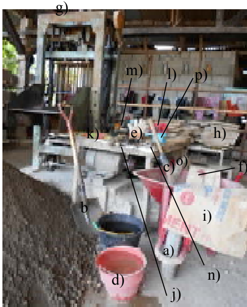
Gambar 1. Alat-alat kerja untuk membuat batako beton mekanis (Sumber: hasil dokumentasi, 2016)
