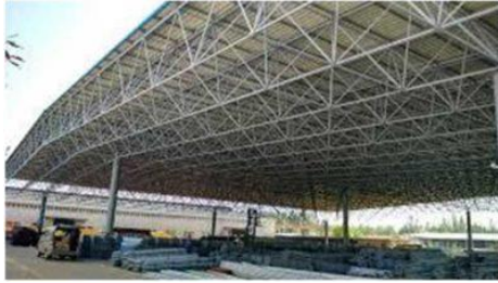
Gambar 4.13 Konsep Konstruksi Atap Struktur Space Frame
