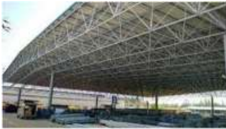
Gambar 4.13 Konsep Konstruksi Atap Struktur Space Frame
