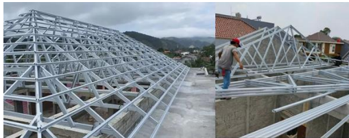
Gambar 26 struktur baja ringan
