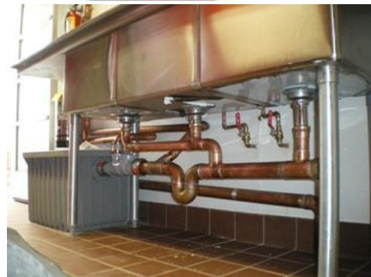
Gambar 14 Septitank Biorich dan Greasetrap
