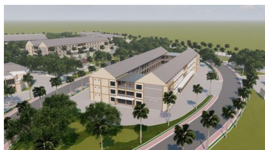
Gambar 33 gedung jurusan agribisnis
