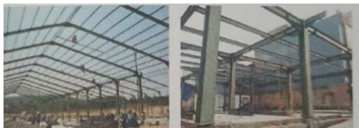
Gambar 10. Kolom dan Balok Baja Konvensional
