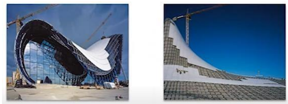
Gambar24. Penutup material GFRP pada bangunan pengelola
