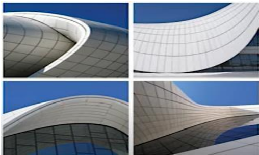
Gambar21. Penutup GFRP pada bangunan pengelola
