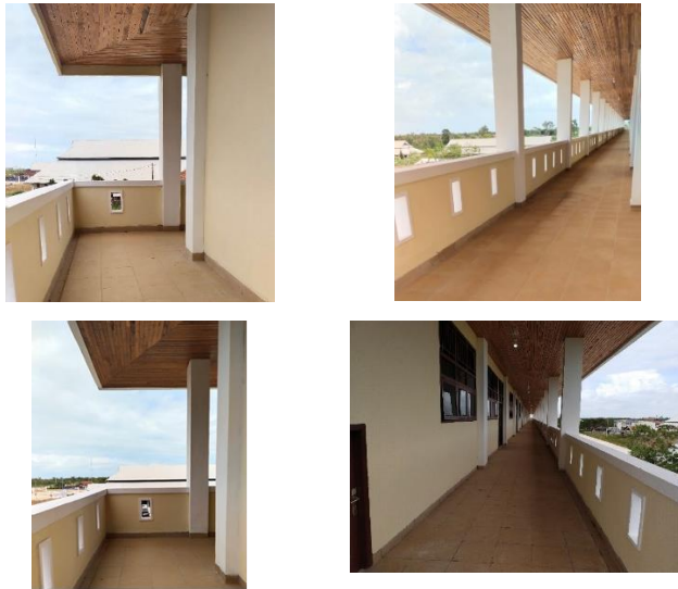
Gambar 14. railing beton sekitar selasar lantai 2 dan lantai 3
