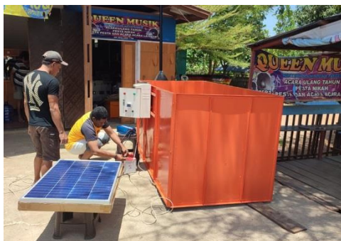
Gambar 2. Instalasi bak pengering dan solar cell
