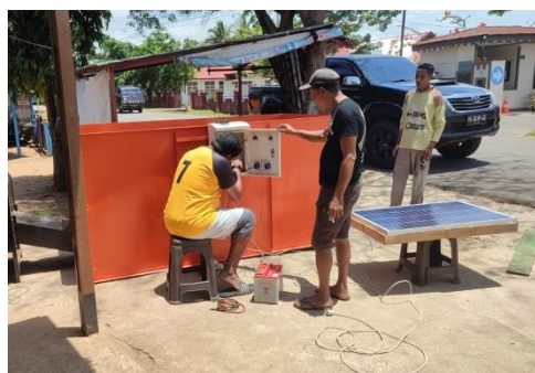
Gambar 4. Perakitan control panel dan solar cell
