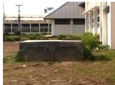
Gambar 10. Penampungan Air Upfeed System Program Studi Teknik Elektro
