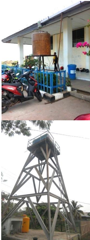
Gambar 11. Penampungan Air Downfeet System Program Studi Teknik Mesin (kiri) dan Program Studi Teknik Sipil (kanan)
