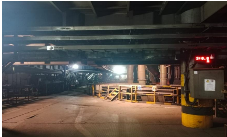
Gbr. 4. Pemasangan Perangkat pada Area Tapping Tungku Furnace
